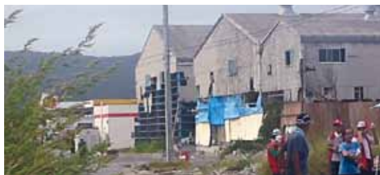
津波で壁が流された工場
